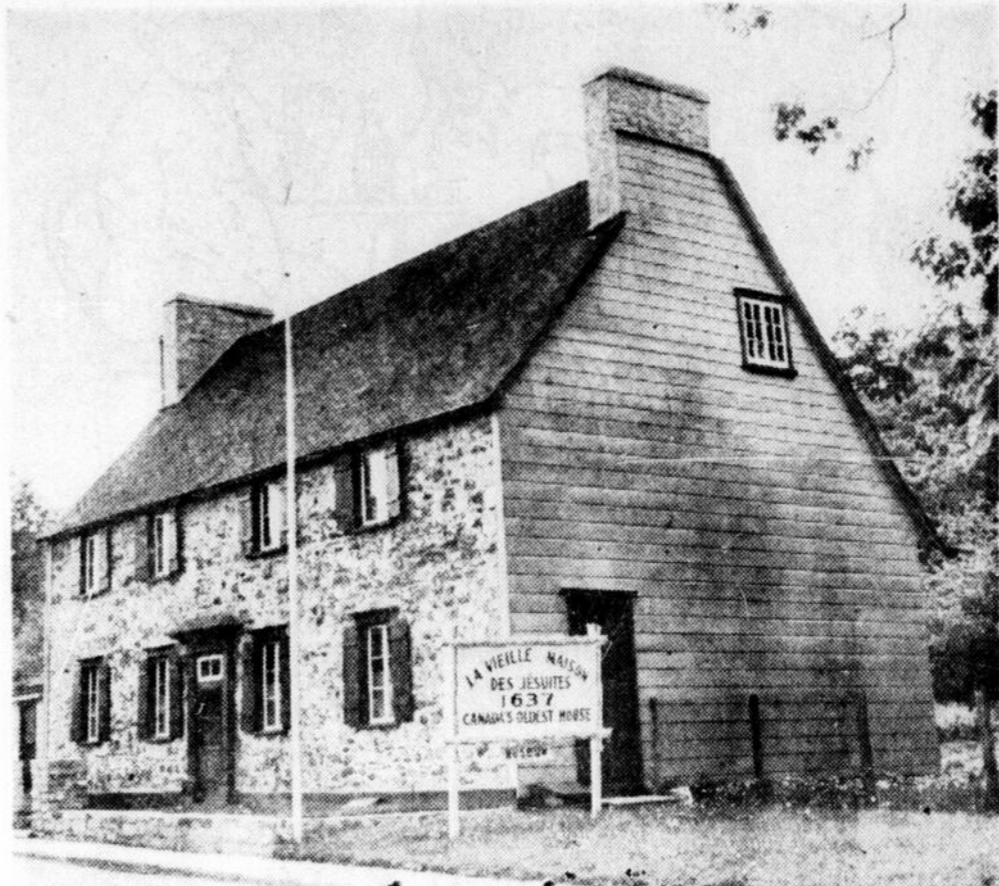
LA VIEILLE MAISON DES JÉSUITES a été construite en 1637. Le père Massé y mourut le 12 mai 1646. Il fut inhumé dans la chapelle St-Michel qui était construite face à la maison. Eur son site s'élève le monument Massé.
