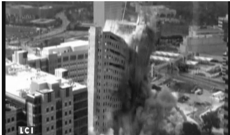
Démolition contrôlée, d'un édifice en Houston –Texas en 2010
