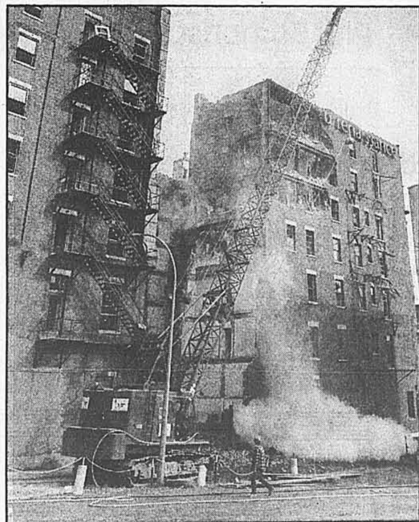
La démolition est déjà commencée.
