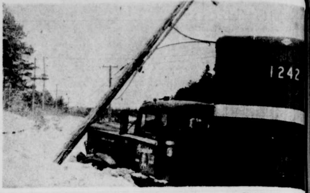
UN POTEAU de la Shawinigan Water and Power a été sectionné par un camion-remorque de Champlain Express. L'accident est survenu sur l'île Melville vers 9h30 hier matin. Le chauffeur du camion, M. Joseph Damerou, a voulu éviter un auto et c'est alors qu'il perdit le contrôle de son lourd véhicule sur la chaussée glissante. Personne ne fut blessé et le camion a subi pour environ $600 de dommages. La circulation a été arrêtée durant quelque quinze minutes. Une longue file d'auto n'a pas été en mesure de se former.
