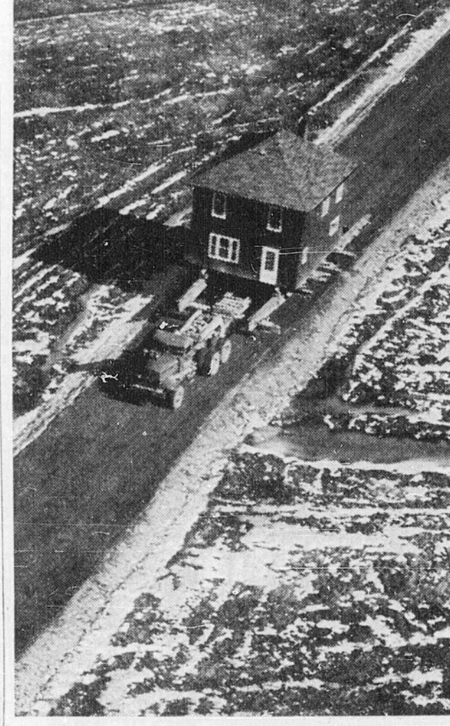
NON, CE NE SONT PAS DES JOUTES, même si cette nouvelle formule le transforme en un jeu d'enfant pour la ménagère. Il s'agit ici d'un véritable déménagement, vers la nouvelle ville "pré-construite" de Long-Sault. C'est l'une des dernières maisons à quitter le village de Moulinette qui sera bientôt submergée par le passage de la Voie maritime du Saint-Laurent. Des opérations de ce genre se répèteront bientôt dans la région voisine de Morrisburg.
