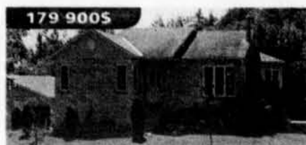
179 900$ 179 Chemin Mont-Cascades, Cantley: Magnifique bungalow de qualité supérieure, Bois franc partout, poêle à combustion, armoires en chêne, grande s/bain avec jacuzzi/douche séparée, s/sol aménagé avec s/bain complète. Triple deck donnant sur piscine. Garage double. Possibil. de louer 6 acres pour chevaux. Visitez l'intérieur à www.reseaucourchesne.com . SIA 028668
