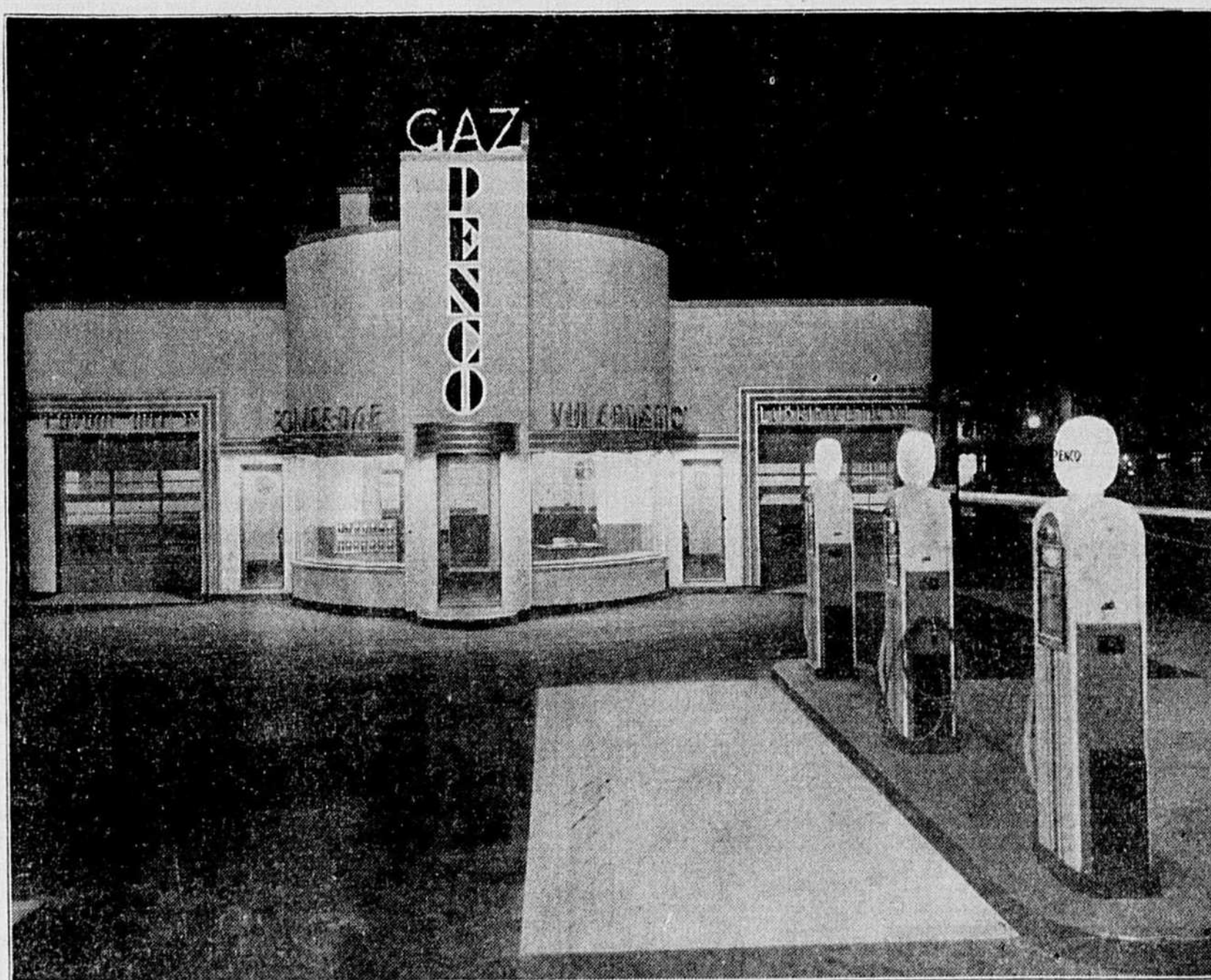
Photographie montrant le nouveau poste de gazoline que vient d'ériger M. J.-A. Roy, au coin du BOULEVARD CHAREST et des rues ST-DOMINIQUE et STE-MARGUERITE.
