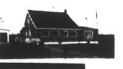
63. LACOLLE: rénové en 1980, possédant 10 grandes pièces, situé à 2 minutes des services, 63 500$. Mario Raymond
