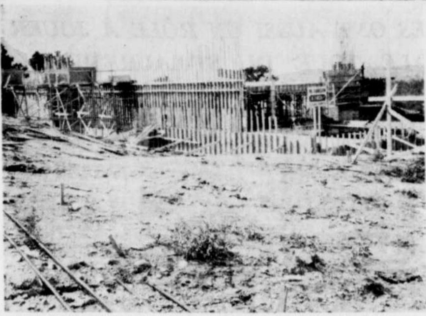
UN IMPORTANT CHANTIER. — La nouvelle église St-Aimé prend forme à l'angle du boulevard St-Luc et de la rue Coulston à Asbestos. Le contrat a été confié à la firme J.-M. Jeanson, de Sherbrooke. (Photo La Tribune, par Jacques Drapeau)
