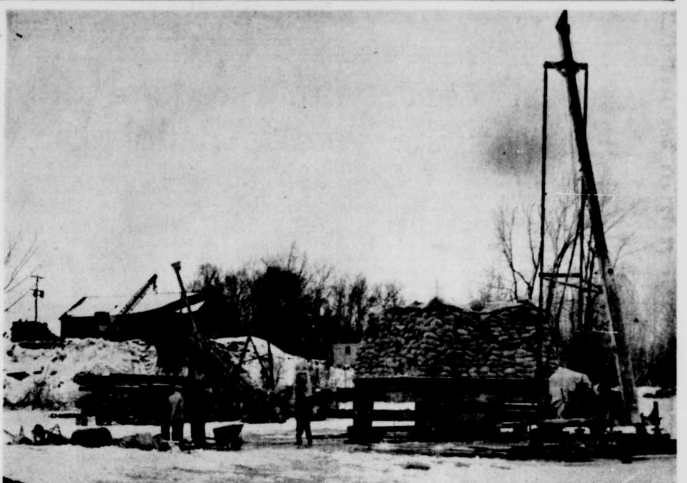
LA COMPAGNIE FRANKI PILES, depuis hier, travaille jour et nuit à la pose des pilotis qui serviront à asseoir les piliers du pont de l'île St-Quentin. Hier, elle a fait une expérience tout à fait spéciale pour démontrer que la ville pourrait économiser une somme de plus de $7,500 avec les pieux Franki. La photo ci-dessus nous fait assister au test fait avec une charge de 75 tonnes sur un pieux tubé Franki à base élargie. Plus tard dans la journée, la charge a été portée à 120 tonnes. Après une période de quatre heures, l'affaissement constaté était de moins de trois quarts de pouce, ce qui selon l'expertise de la compagnie se situe dans la normale des exigences techniques.
