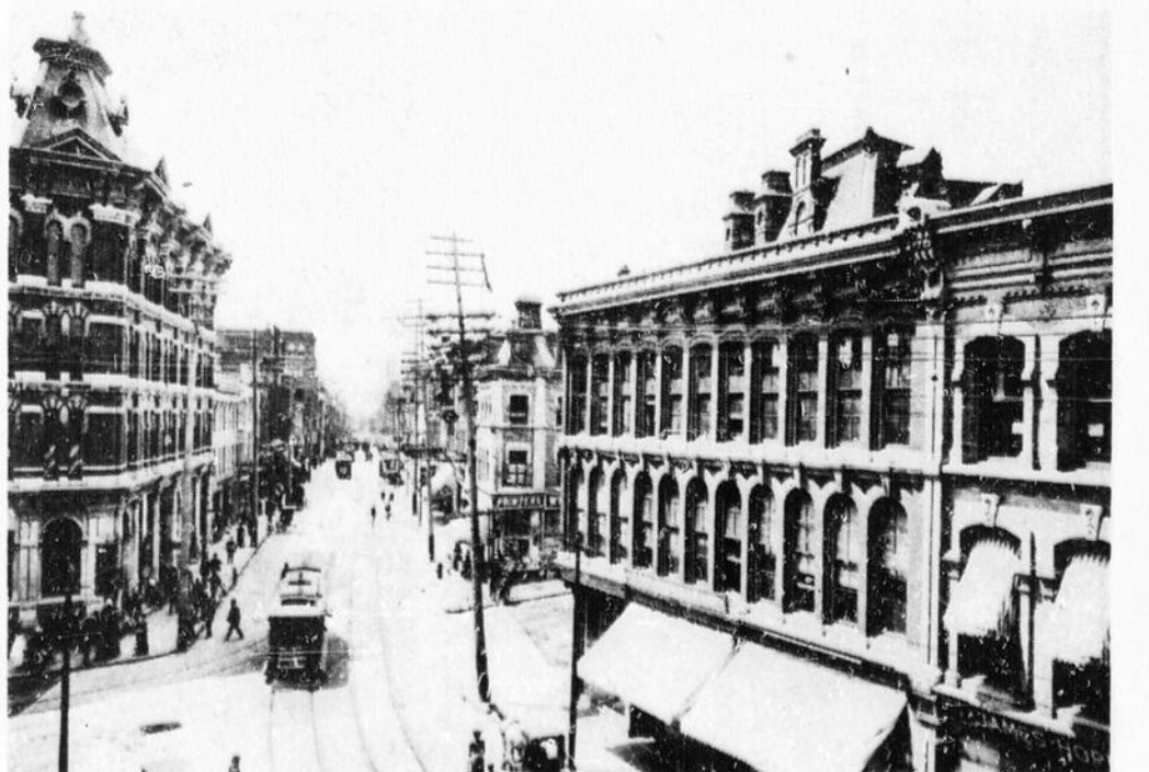
Vue de la rue Sparks à la fondation du DROIT
