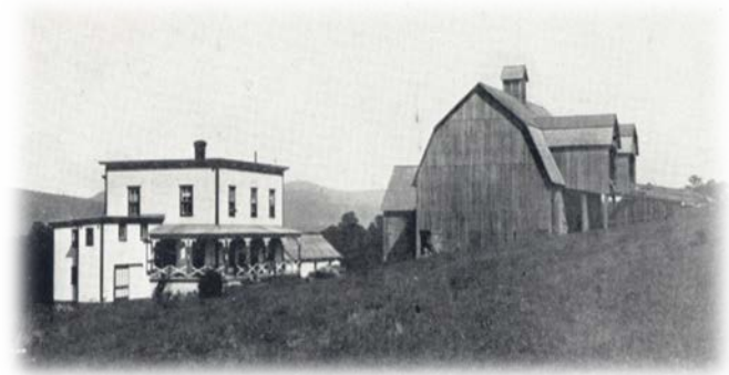
La ferme en 1937 Photographie de E. M. Taylor
