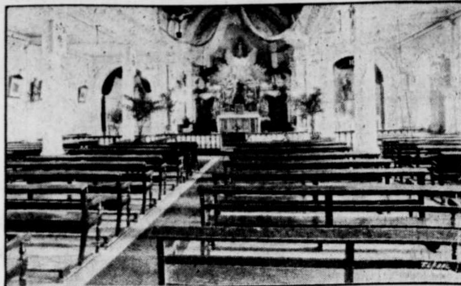
La chapelle du patronage fut détruite par un incendie, en 1966, alors qu'elle venait d'être restaurée.
