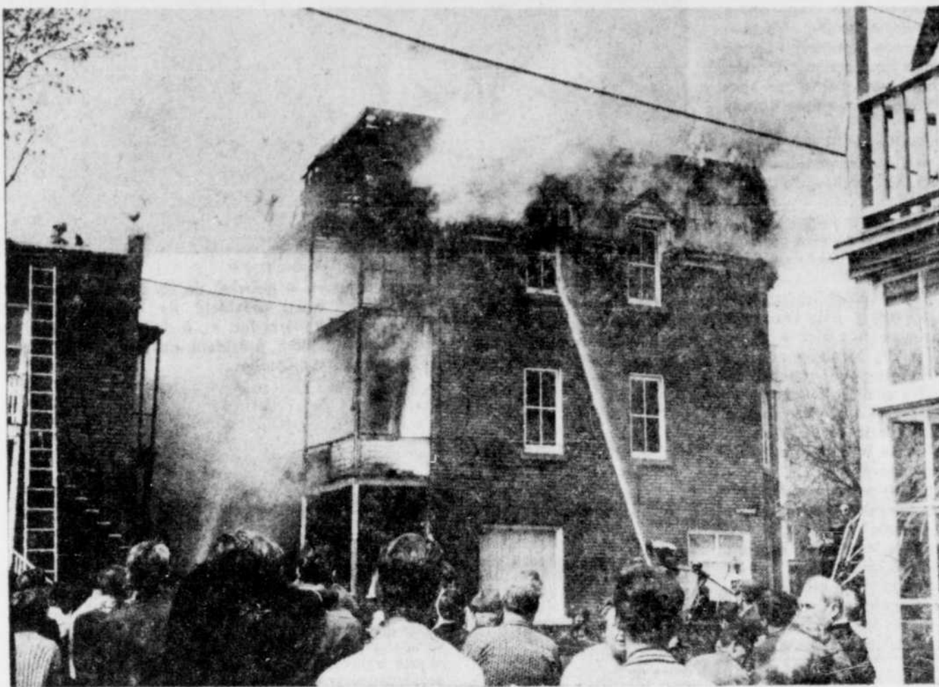
LA CIRCULATION a été interrompue durant plusieurs heures aux environs de l'intersection de la 2e Rue et de la Rue Tamarac à la suite du violent incendie qui
