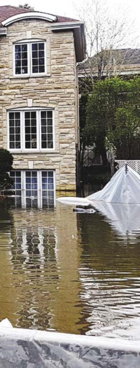
◀ Inondations à Montréal en 2017 Photo: Coastal Elite
