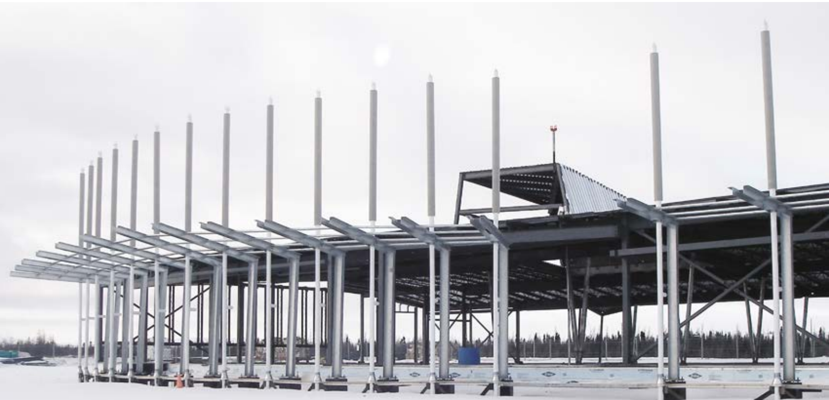
Aérogare de Kuujuaq (en construction), EVOQ Architecture Photo : EVOQ Architecture
