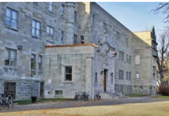
▲ École secondaire Sophie-Barat, Montréal, David Jerome Spence Photo : Parcours riverain - Ville de Montréal
