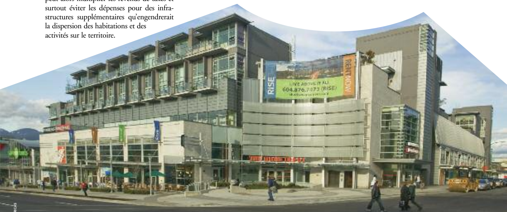
Édifice The Rise, en périphérie de Vancouver
