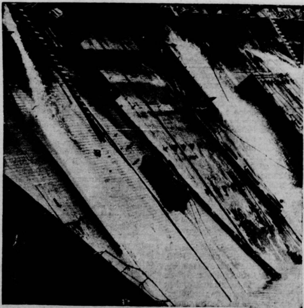
Le renflouement fait continuellement du progrès. Ici, le luxueux paquebot, dégarni de sa superstructure, venait d'être soulevé à un angle de 47 degrés. On voit l'eau ruisseler sur les ponts comme des cascades, pendant que les pompes puissantes fonctionnent pour aspirer les 46,000 tonnes d'eau qu'il reste à sortir de la coque. On prévoyait alors qu'il fallait encore plusieurs semaines pour en finir avec le renflouement.
