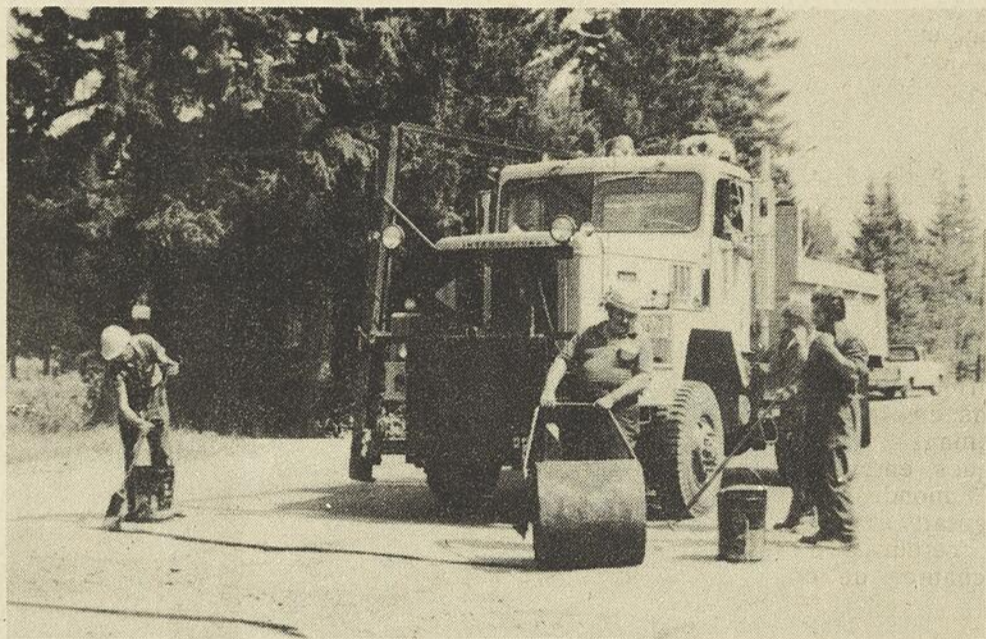
Les employés de la Municipalité procèdent aux préparations temporaires de la rue de l'Eglise. Il paraît que ce n'est pas drôle d'étendre de l'asphalte durant les chaleurs de juillet. Photo Gilles Morin.
