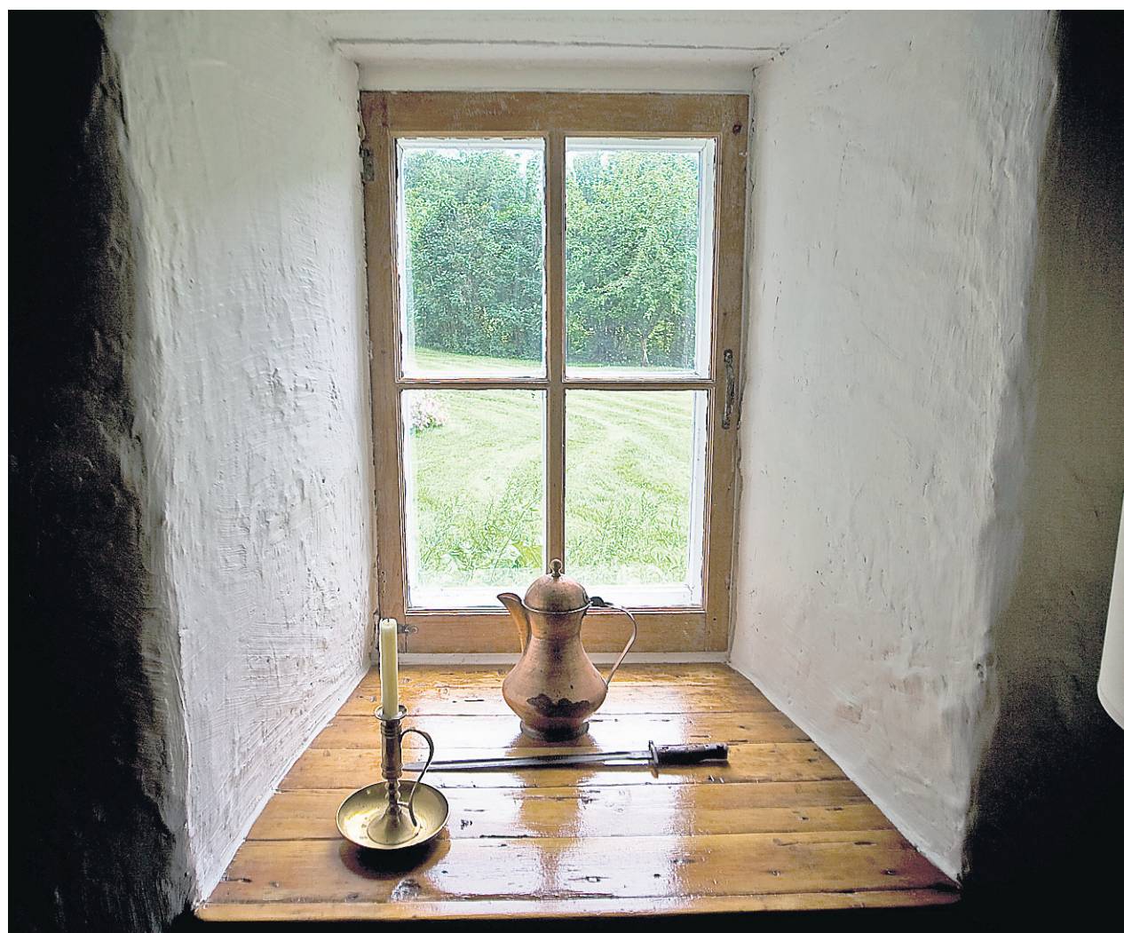
Au rez-de-chaussée, les murs font pratiquement un mètre d'épaisseur.
