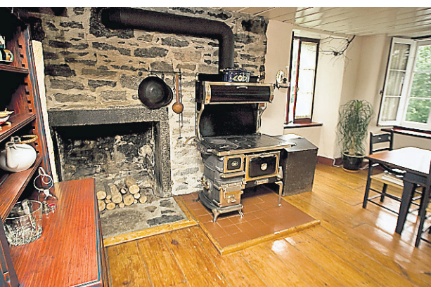
Un poêle au bois Findlay Oval sert pour cuisiner et chauffer la maison (en plus des plinthes électriques).
