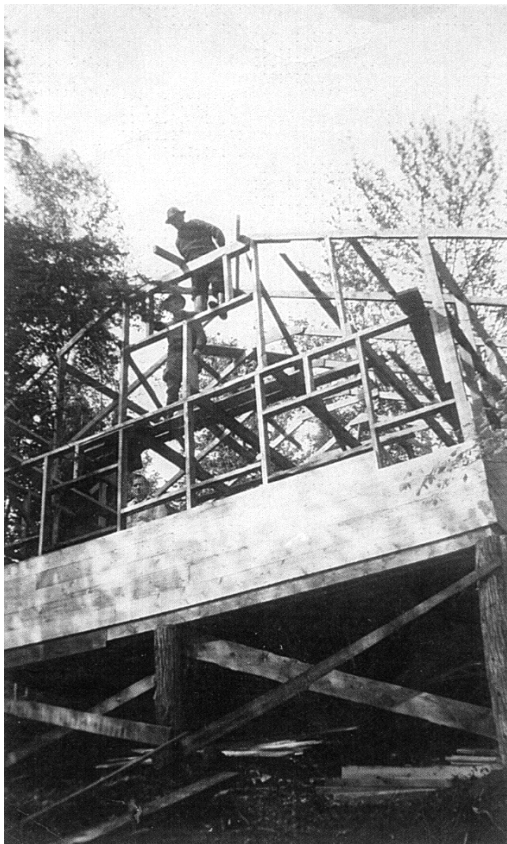
Figure 32 La construction du chalet des Martineau, en 1950. Source : collection de Lise Dubois et Jean-Guy Ledoux.
