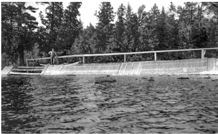
Figure 2 Barrage à claire-voie à la décharge du lac Fraser, 1932. Source : BAnQ. 6
