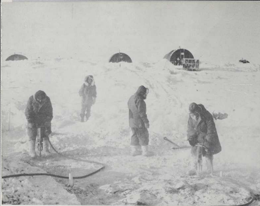
LES EXCAVATIONS POUR LES FONDATIONS DES TOURS, DANS LA TOUNDRA GLACÉE, NECESSITENT LE DYNAMITAGE ET L'UTILISATION DE MARTEAUX-COMPRESSEURS.
