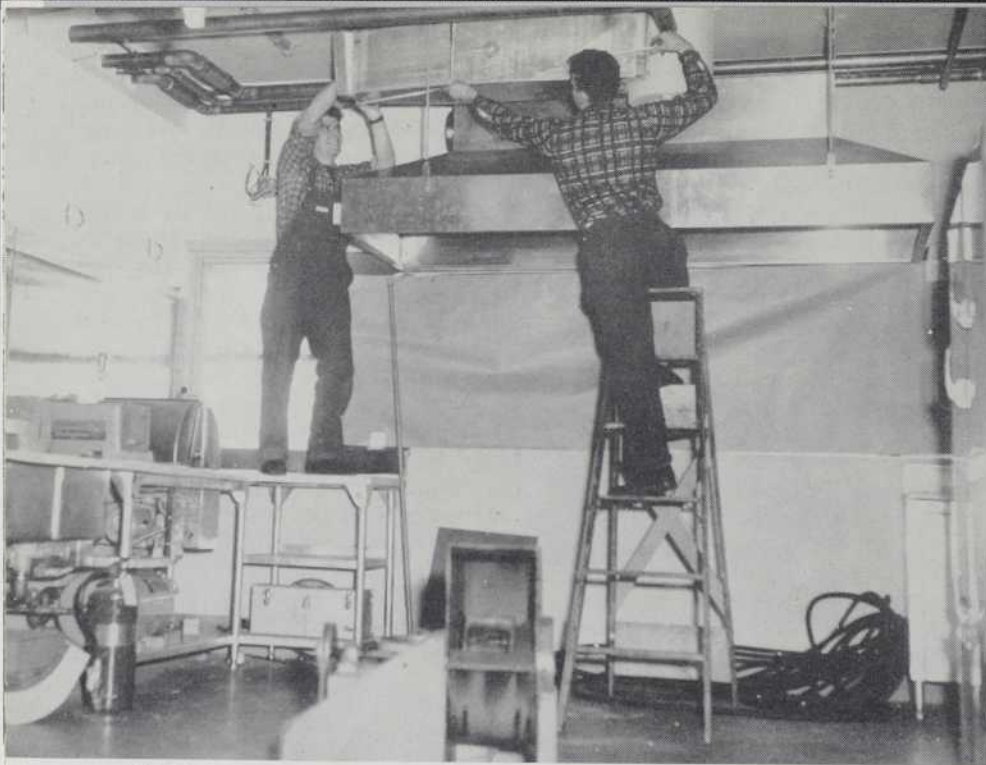
INSTALLATION D'UNE CUISINE DANS UN "MODULE," A UN POSTE DE RADAR.
