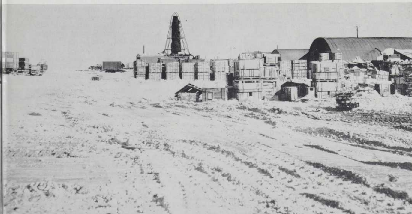
"SUR LES LIEUX" : QUELQUES-UNS DES AMONCELEMENTS DE MATERIAUX NECESSAIRES POUR LA CONSTRUCTION DE LA LIGNE DEW.
