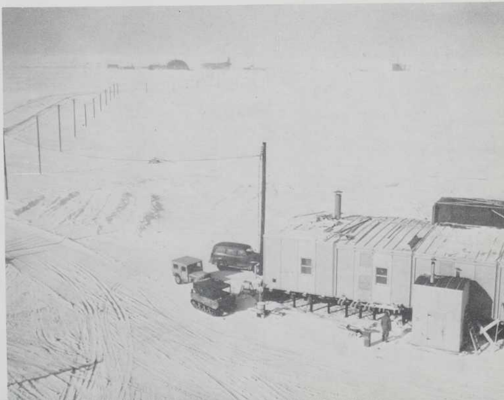
EN CONSTRUCTION, UN "TRAIN MODULAIRE" QUI LOGERA LES HOMMES ET L'OUTILLAGE DE LA LIGNE DEW. A DROITE, LA STRUCTURE QUI SUPPORTERA L'ANTENNE ET LA COUPOLE DU RADAR. AU PREMIER-PLAN, UNE EXTREMITÉ D'UN TRAIN MODULAIRE, ELEMENT DE BASE D'UN POSTE DE LA LIGNE DEW. A L'ARRIERE-PLAN, LE CAMP DE CONSTRUCTION DU POSTE.
