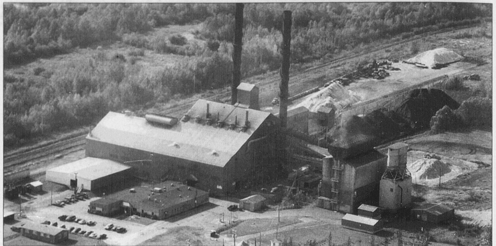
USINE - Les dirigeants d'Elkem Metal considèrent se comporter en bons citoyens corporatifs. Même que l'entreprise n'exploite pas la ressource hydraulique autant qu'elle aurait le droit de le faire selon l'entente la liant à Québec.
