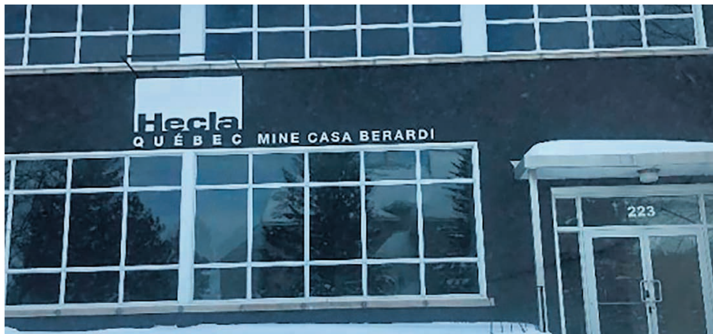
Les nouveaux locaux administratifs de la mine Casa Bérardi sont situés au 223 Ave. Principale à La Sarre. (Photo : Gracieuseté – Hécla-Québec)
