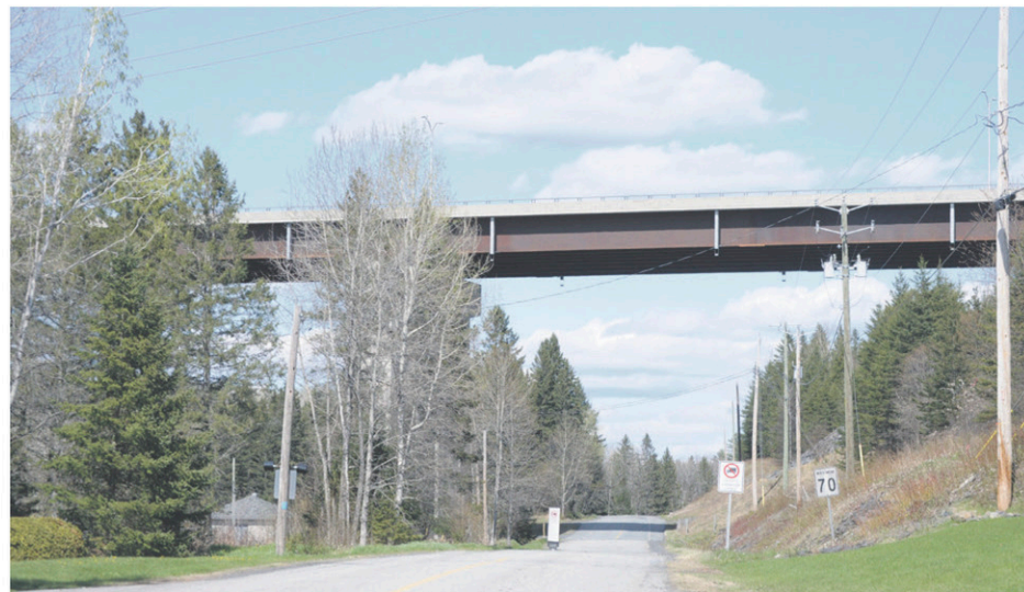
Des barrières dissuasives pourraient être installées sur le viaduc.
