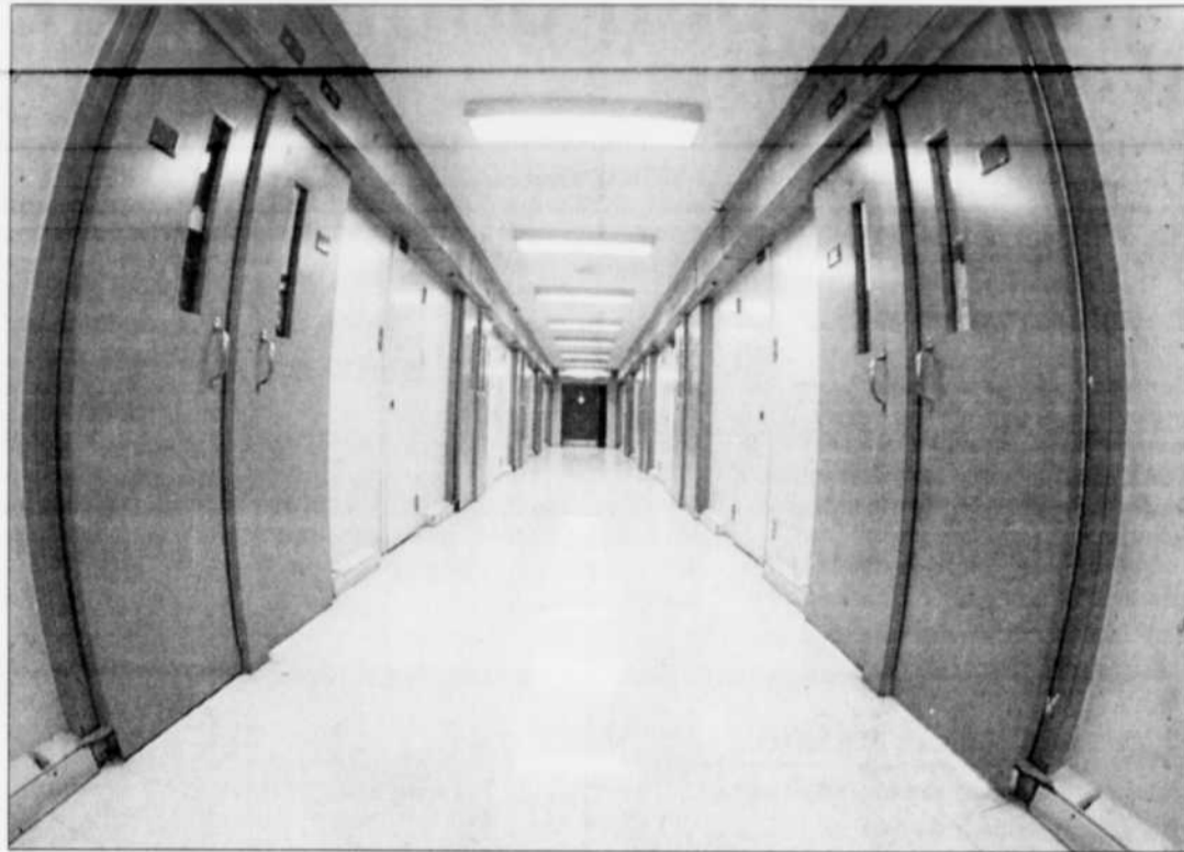
Une rangée de cellules du pavillon L du pen de Donnacona, fraîchement réaménagées.
