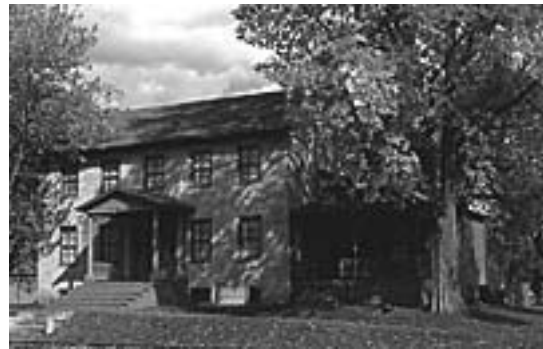
Maison Brisbois après restauration (Photo J. Draeger, 2003)
