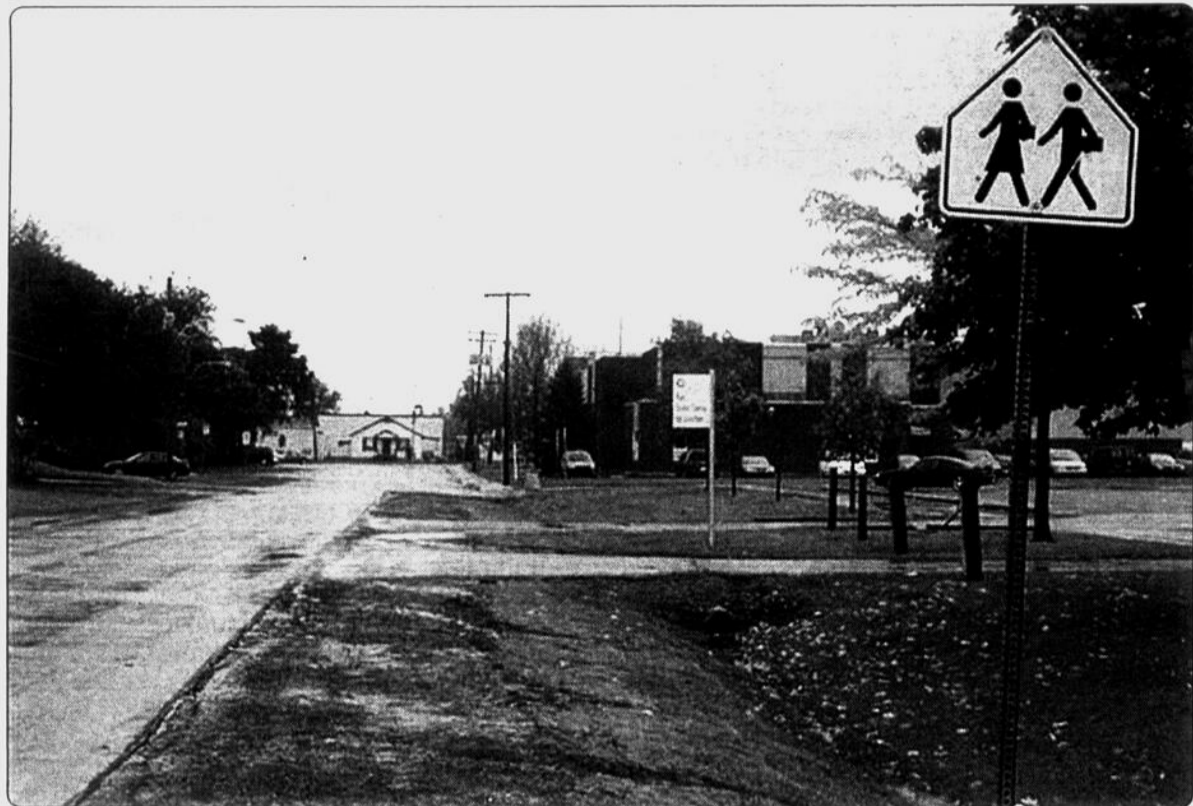
Pour des raisons de sécurité, des parents d'élèves de l'école NDL demandent que soit complétée la rue Plaza, sur sa section étroite, bordée d'un fossé et sans trottoir.
