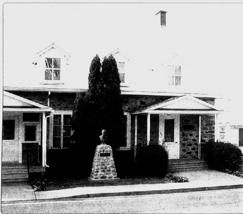
C'est dans cette maison de pierres, située face à l'église actuelle, que le frère André a été baptisé, le 10 août 1845. Une plaque souvenir est apposée sur le mur extérieur.
