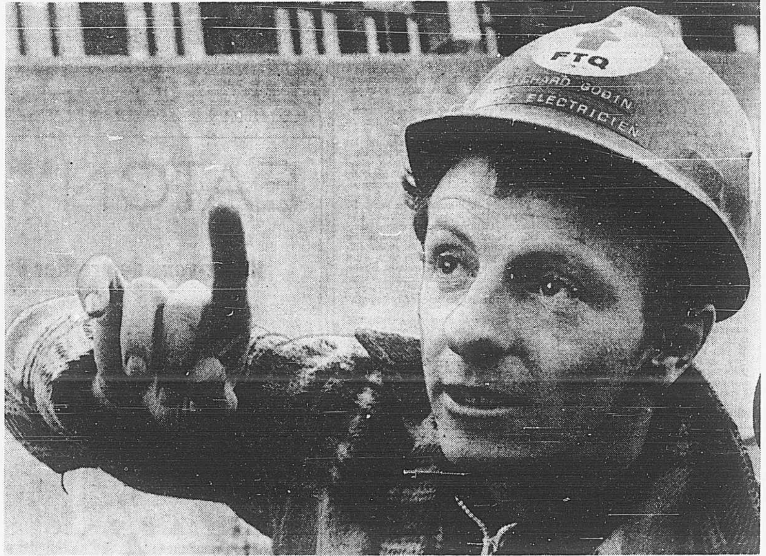
"J'ai vu à un moment donné du sang couler le long des murs de béton", explique M. Richard Godin, apprenti électricien.
