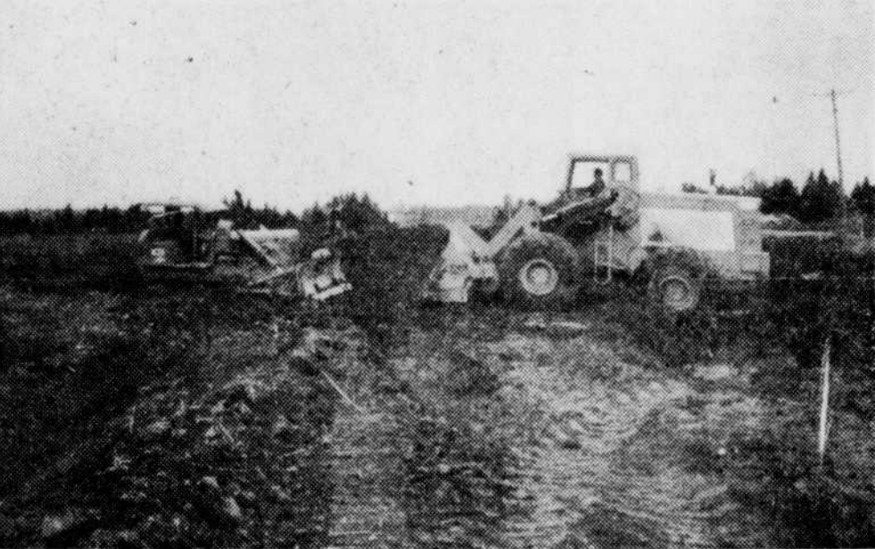
D'IMPORTANTES TRAVAUX s'effectuent présentement sur le chemin du Bassin, à East Angus. Il s'agit de l'élargissement du chemin sur une longueur de 300,000 pieds. Ces importants travaux sont de l'ordre de $40,000 et sous la direction de M. Ernest Croteau, de Cookshire. (Photo La Tribune, par Mme G. Pomerleau)
