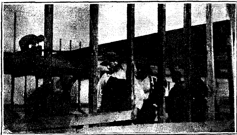
58.—ON COMMENCE L'HÔPITAL
