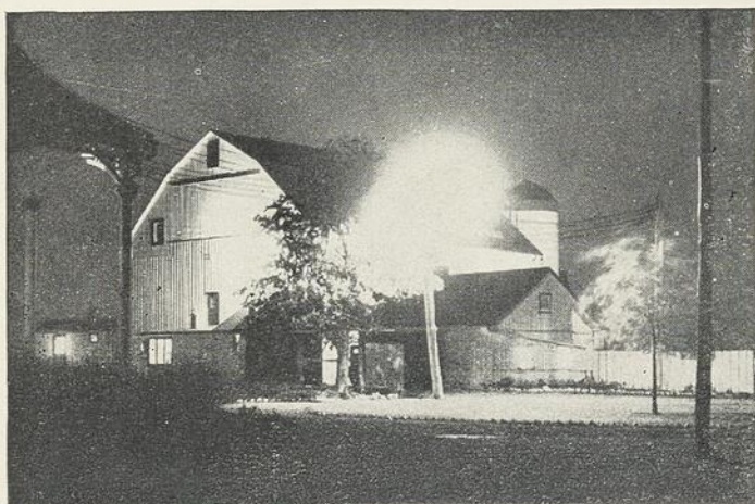
ÉCLAIRAGE EXTÉRIEUR —les tâches de la soirée s'en trouvent facilitées. Vous avez plus de temps pour des travaux productifs, vous protégez votre propriété, vous diminuez les risques d'accident.
