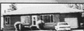
Accrédité pour garderie, maison d'accueil, zoné comm., toit refait, planch. b.f., très propre
