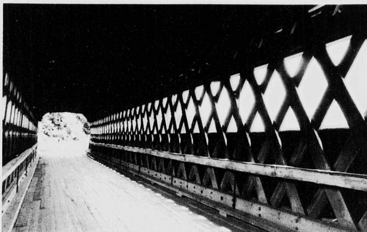
Tous les ponts couverts en Estrie, à l'exception de un, ont été construits selon le modèle Town reconnu pour sa grande simplicité dans le montage de la structure. Il s'agit, ici, du pont de Gould.
