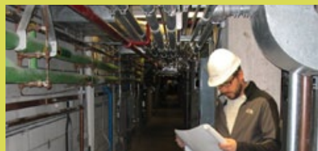
LÉONARD RELÈVE DU GÉNIE-CONSEIL RÉAMÉNAGEMENT DU LABORATOIRE D'ÉTALONNAGE DE L'INSTITUT DE RECHERCHE D'HYDRO-QUÉBEC (IREQ) À VARENNES, PAR SIMON NOLIN, ING., LEED AP BD+C
