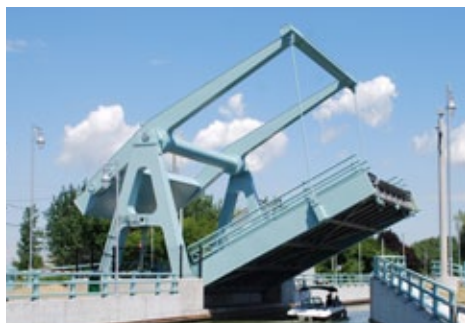
LÉONARD INFRASTRUCTURES DE TRANSPORT NOUVEAU PONT LEVANT NO 9 AU-DESSUS DU CANAL DE CHAMBLY ENTRE CARIGNAN ET SAINT-JEAN-SUR-RICHELIEU
