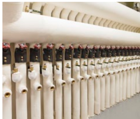
LÉONARD BÂTIMENT MÉCANIQUE - ÉLECTRIQUE CONSTRUCTION DE LA MAISON DU DÉVELOPPEMENT DURABLE À MONTRÉAL
