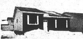
29. ST-JEAN: près hôpital, centre achat, construit 1984, 58,000$, Denis Dépelteau.
