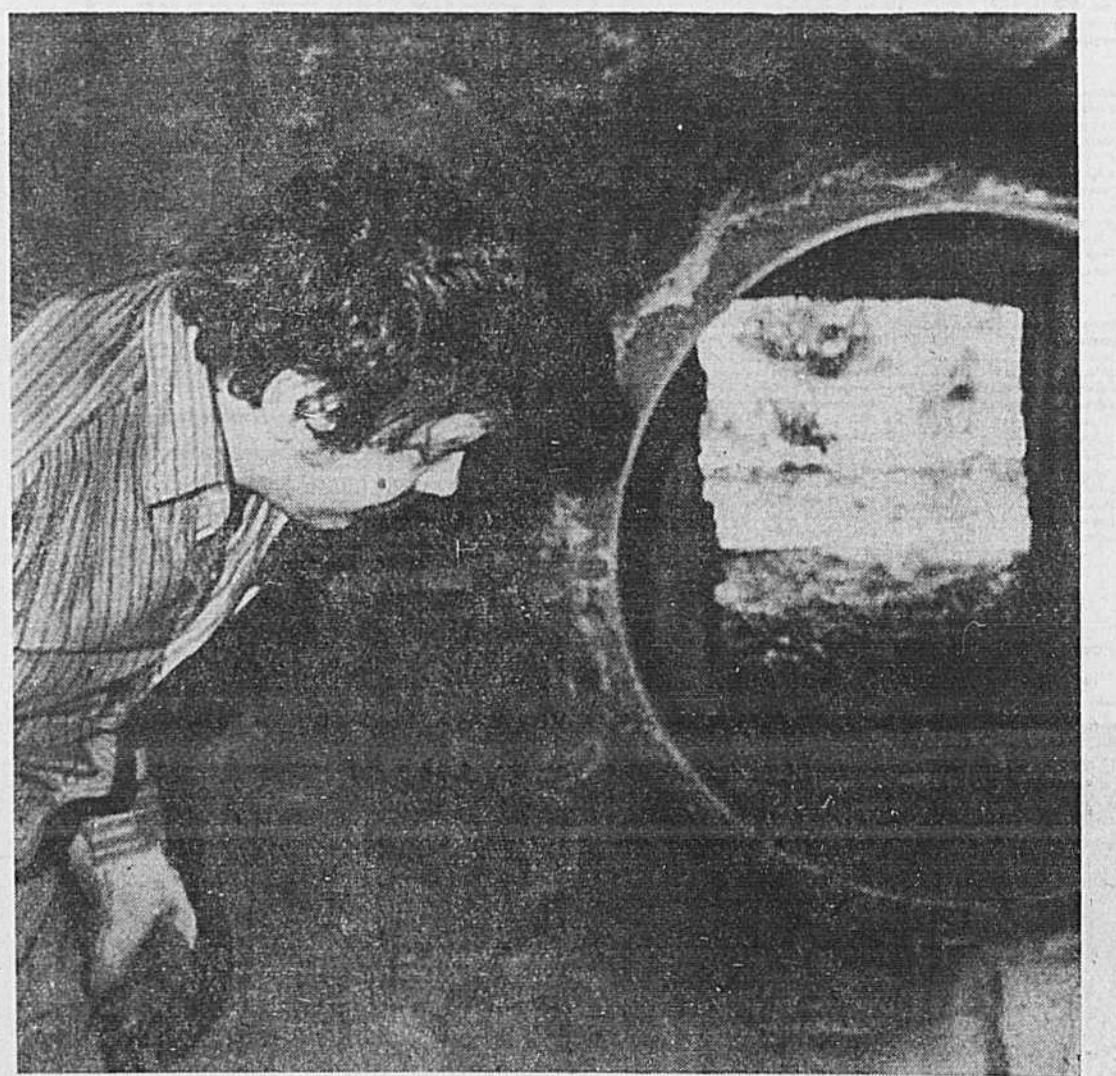
Un employé de la papeterie Scott Maritimes Ltd. à Abercrombie Point, N.-E., examine un poêle qui brûle des écorces et des rognures de bois provenant de la fabrication de la pulpe. En brûlant ces déchets, l'usine fait des économies, ce qui n'est pas négligeable au prix actuel de l'huile.
