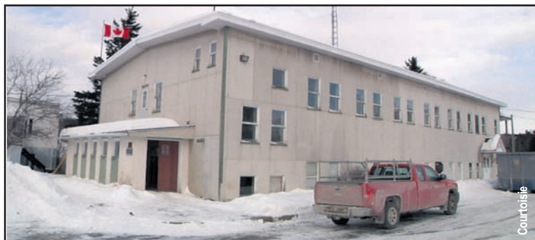
L'édifice municipal de Sacré-Cœur sera presque entièrement reconstruit après les travaux de décontamination.
