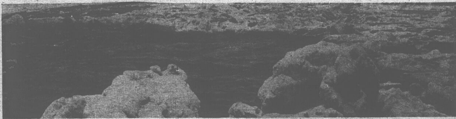
(Photo Montréal-Matin, R. Meloche) Hier, les travaux des dynamiteurs avaient fait dévier les eaux, mais un second embâcle s'était formé plus loin.
