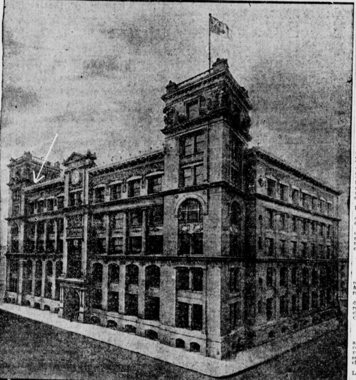
LES MAGNIFIQUES BUREAUX DE LA COMPAGNIE DU GRAND TRONC, rue McGill, qui ont été le théâtre d'un désastreux et mystérieux incendie, ce matin. La flèche indique l'endroit où est située, sous les combles de la tour, la grande voûte où sont conservés les vieux livres et les vieilles archives de la compagnie, et qui ont été dévorés par les flammes.
