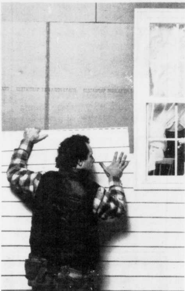
La pose de revêtement extérieur en aluminium ou en vinyle contribue à rajeunir l'apparence d'une maison, à coût modique.
