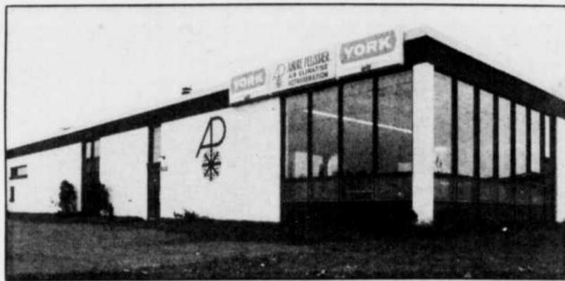
Les bureaux d'André Pélissier Inc. sont situés au 205, rue Godin, à Trois-Rivières.
