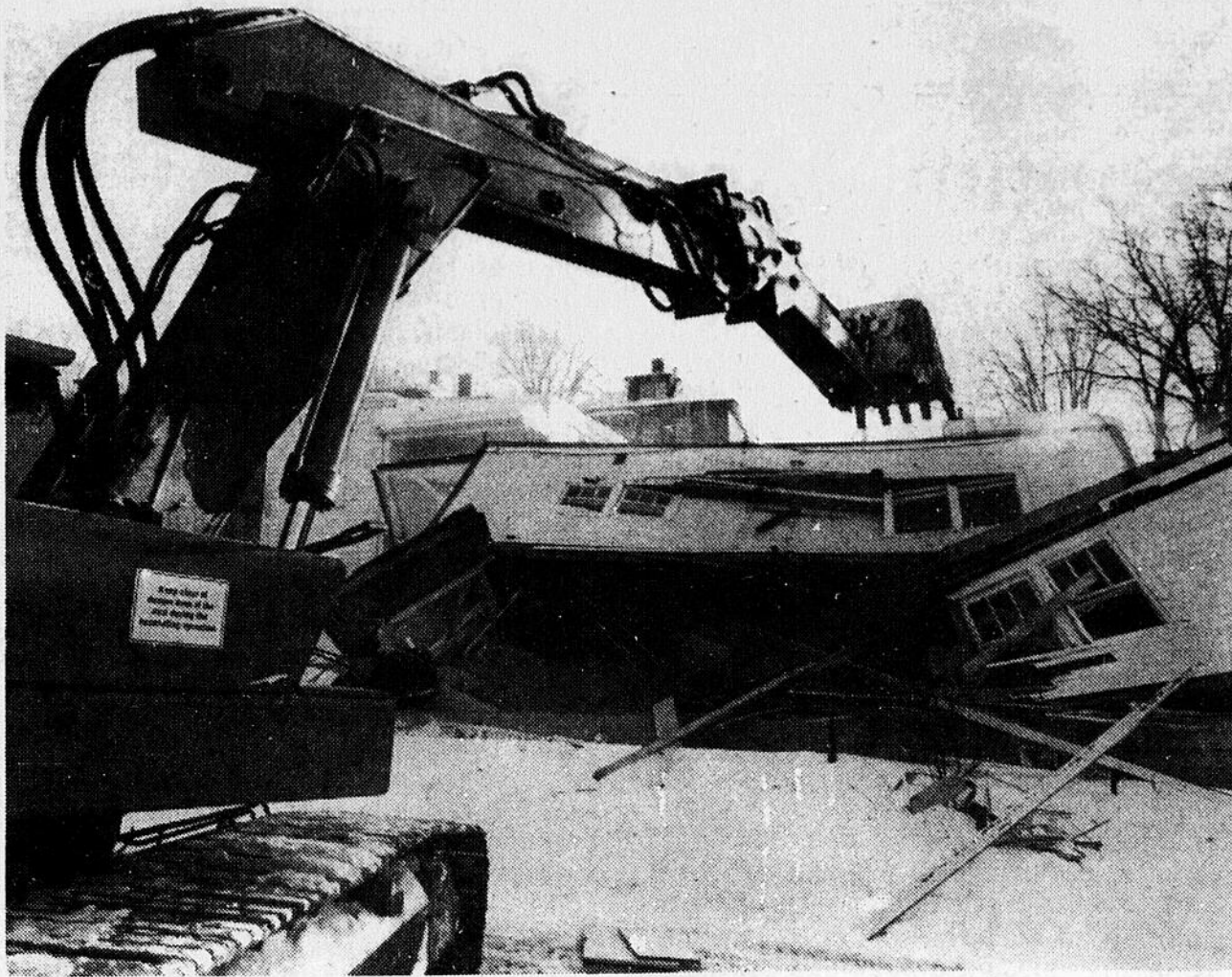
DEMOLITION — Les démolisseurs étaient à l'oeuvre hier sur la rue Lafontaine pour raser deux maisons. Le site est destiné à un complexe de 85 logements pour personnes âgées.
