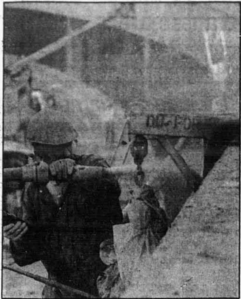
Pas de «vacances de la construction» pour les ouvriers affectés aux travaux de voirie. PHOTO PIERRE LALUMIERE.
