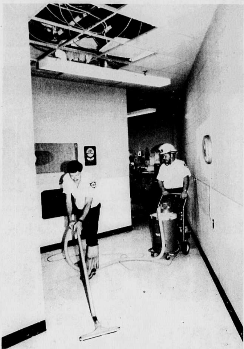
Les pompiers apportent une dernière main au nettoyage qui a suivi le combat d'un incendie, dans le plafond de la salle de mécanique du Cinéma du Carrefour de l'Estrie. Le tuyau d'échappement d'une génératrice a mis le feu.
