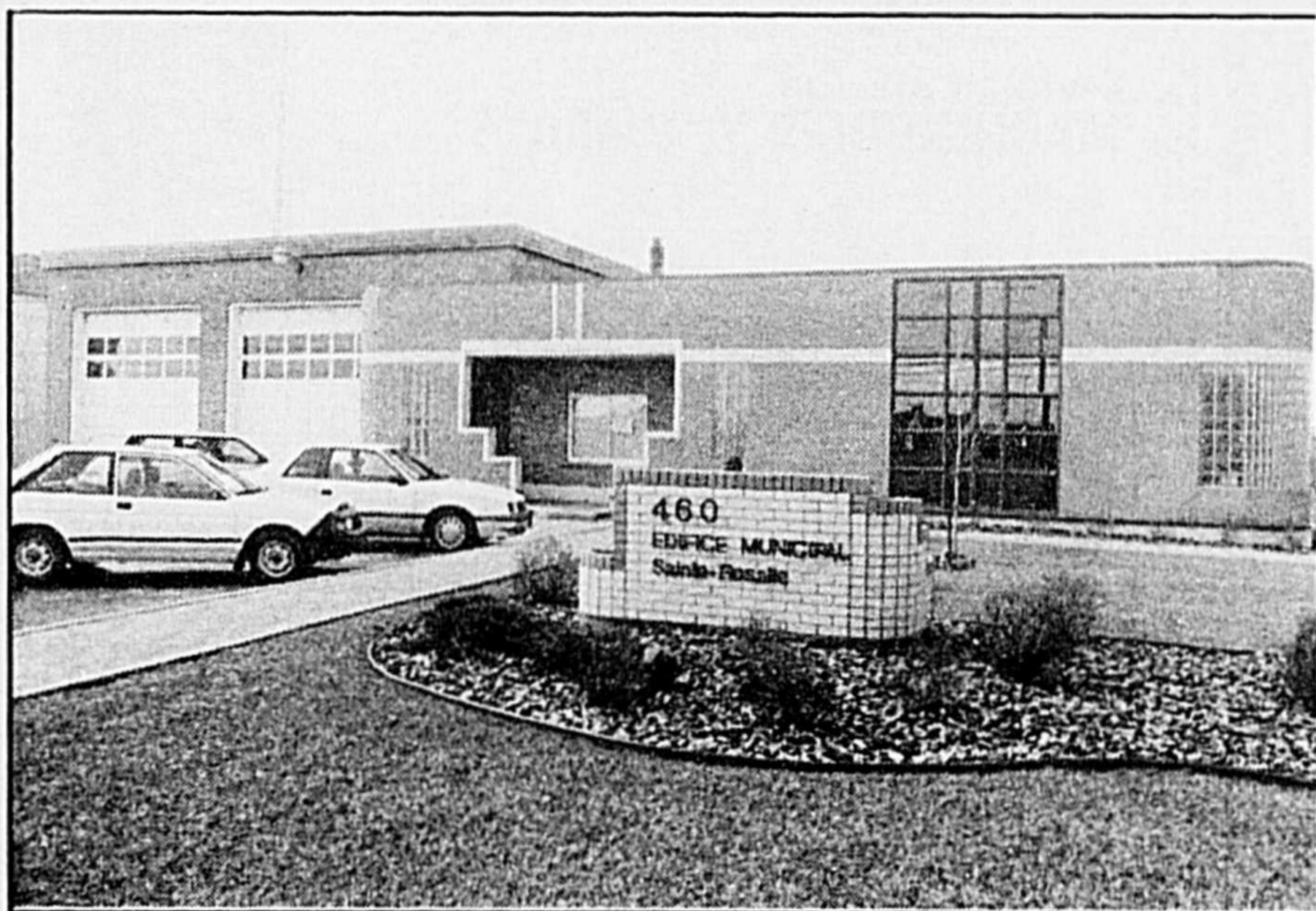
L'édifice municipal du Village de Sainte-Rosalie est situé au 460, rue Marquette. Attenante au bureau, on aperçoit la future caserne de pompiers qui sera fonctionnelle dès le 1er janvier 1992.
