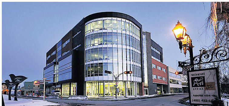
Le nouveau campus de l'Université du Québec en Outaouais à Saint-Jérôme.
