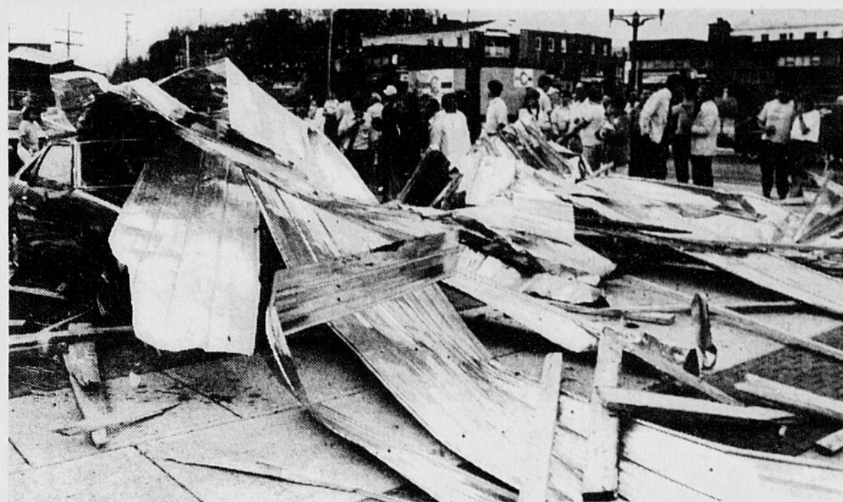
TOIT - La force des vents a emporté une partie d'un toit, à Jonquière, pour se retrouver sur des voitures au centre-ville. Par miracle, il n'y
