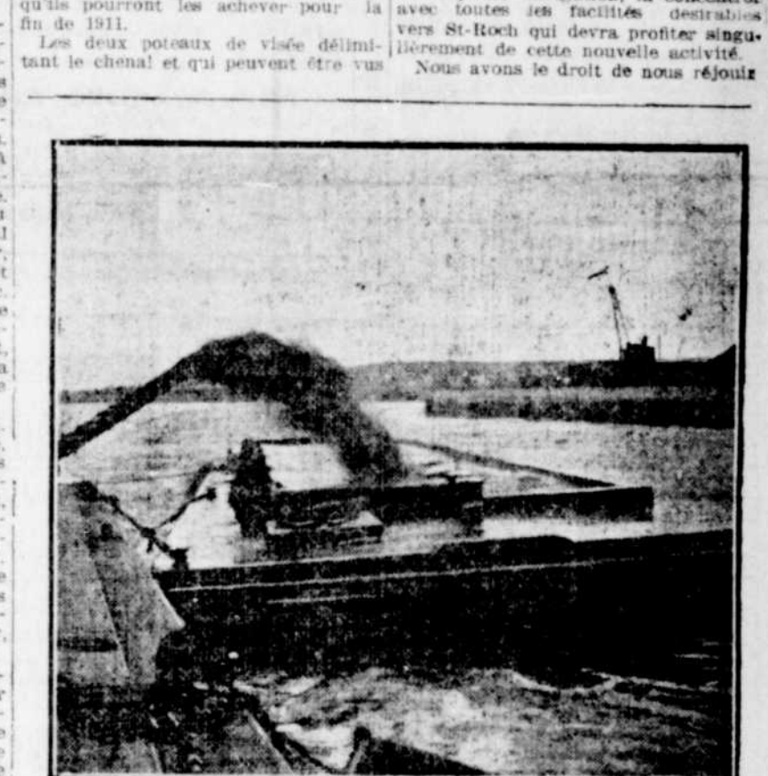
LE JET DE SABLE QUE DEVERSE LA DRAGUE A SUCCION ET LE CHALAND DE DECHARGE
