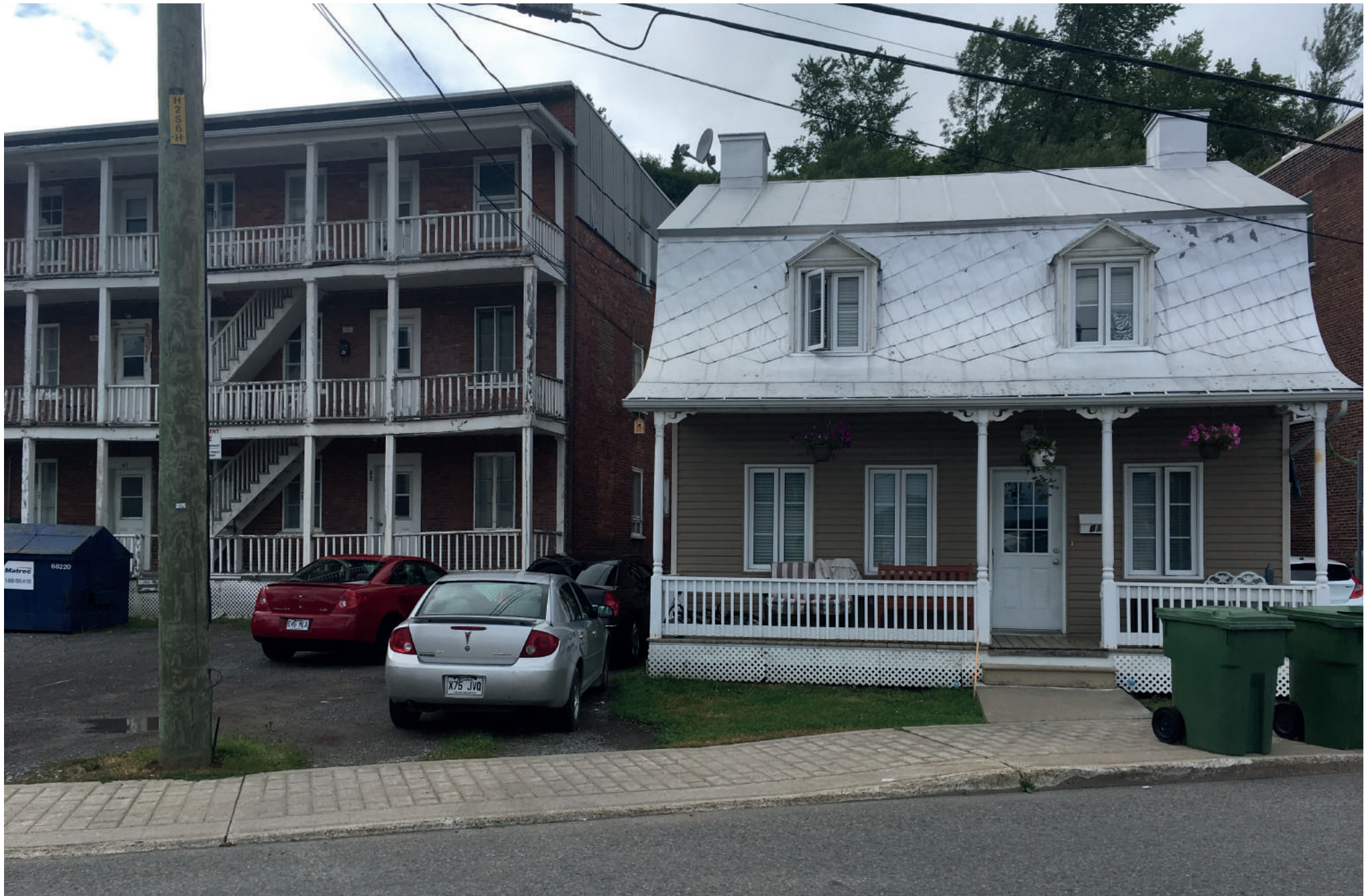
Figure 20 : Aperçu du mauvais état et des différentes formes de bâti retrouvés sur le site à l'étude
