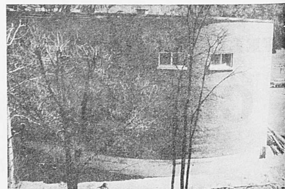
Usine de filtration attachée au moulin de Mont-Rolland
