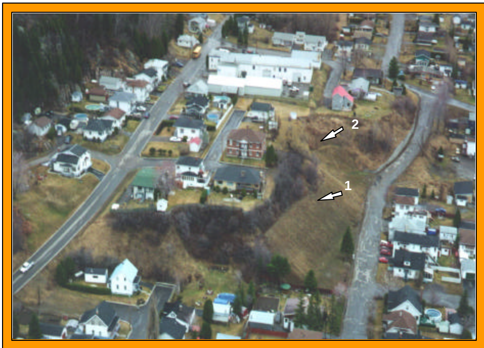
Figure 52 : Vue du contrepoids (flèche n° 1) servant à stabiliser le talus; rue de la Victoire, Chicoutimi.
