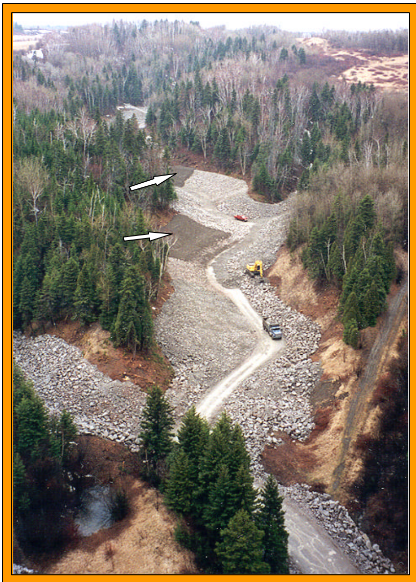
A : Travaux en cours dans le ruisseau Bluteau. Les flèches pointent les endroits où de la terre végétale a été déposée sur l'enrochement.
