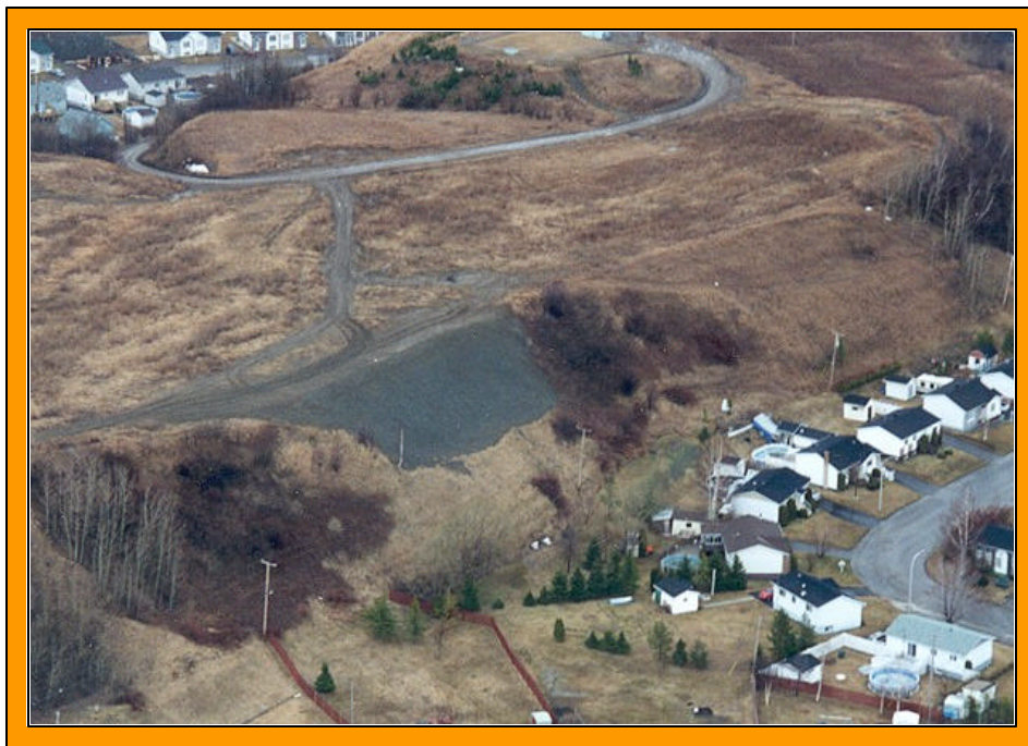
Figure 47 : Adoucissement du sommet de la pente pour stabiliser le talus; rue des Bouleaux, La Baie.
