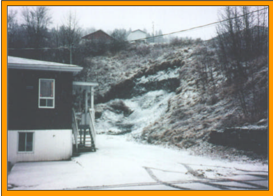
Figure 51 : Glissement de type décrochement ; rue de la Victoire, Chicoutimi. Note : Les débris avaient heurté la galerie et s'étaient étalés dans le stationnement.
