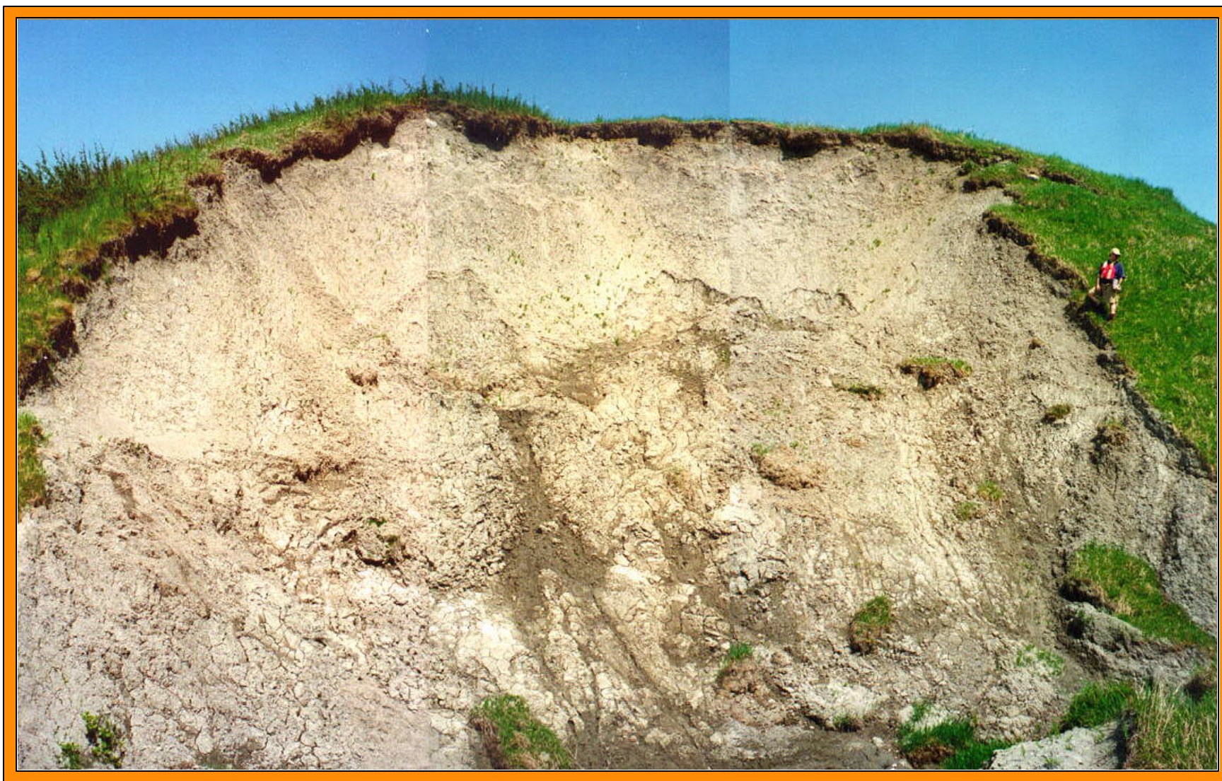
Figure 64 : Important décrochement survenu le long du ruisseau Morissette en juillet 1996.
