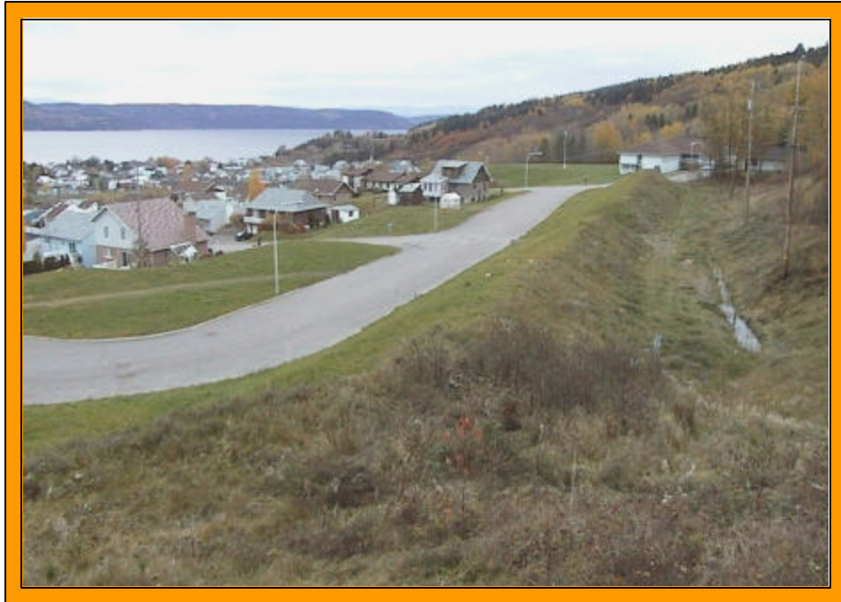
Figure 49 : Vue au sol de la digue en enrochement et fosse de captage; rue Henry-McNicoll, La Baie.
