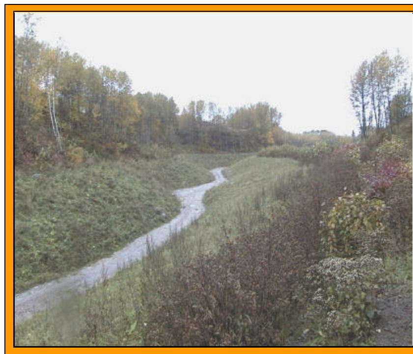
B : Photo prise 18 mois après la fin des travaux dans le ruisseau Beauchemin. La végétation a repris sur les contrepoids. L'eau coule à travers l'enrochement et n'est visible en surface que lors des crues.
