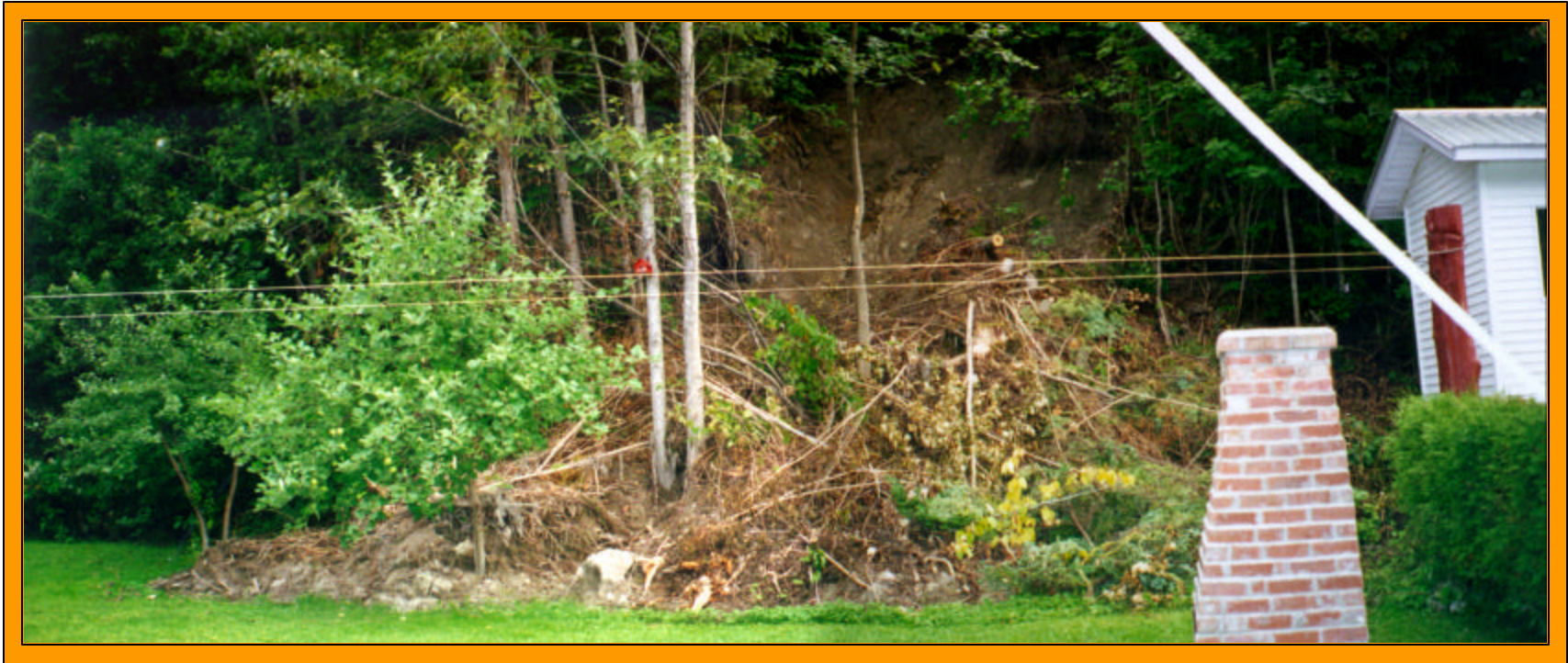
Figure 43 : Glissement superficiel avec étalement des débris à proximité d'une résidence située au pied du talus; rue Eugène-Morin, Petit-Saguenay.
