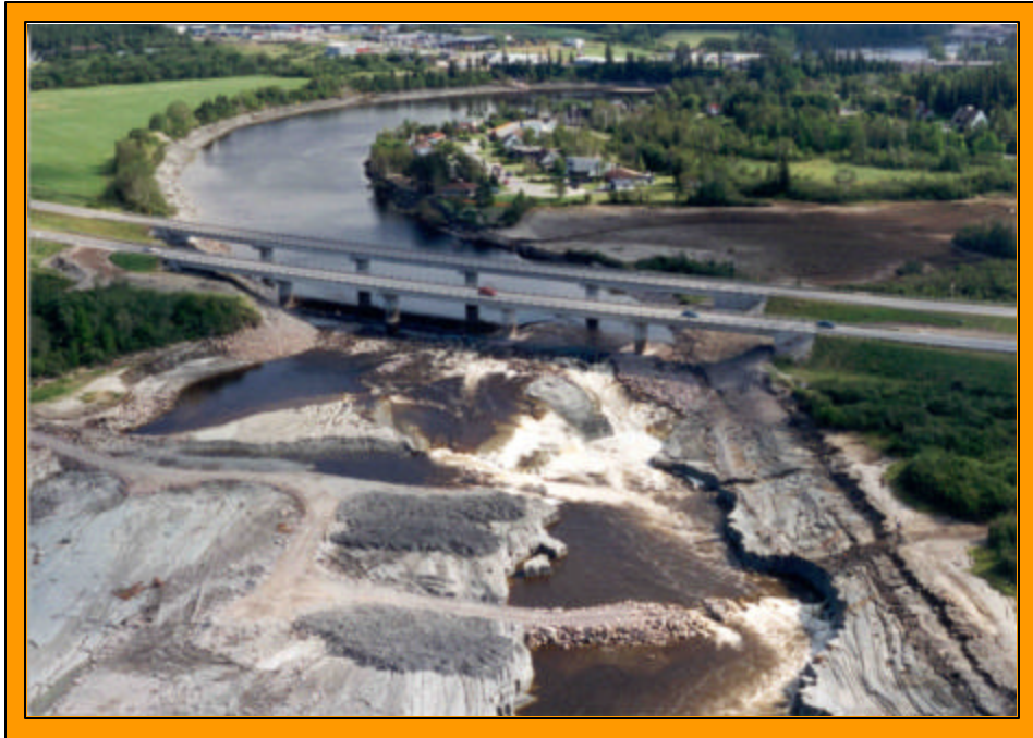
A : Vue vers l'amont en direction du pont de l'autoroute 70. Les piliers ont dû être protégés par empierrement contre l'affouillement.
