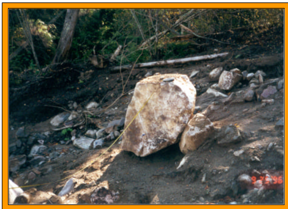
Figure 44 : Bloc rocheux instable dans la cicatrice d'une coulée de débris survenue lors des pluies de juillet 1996 en bordure de la route 172.
