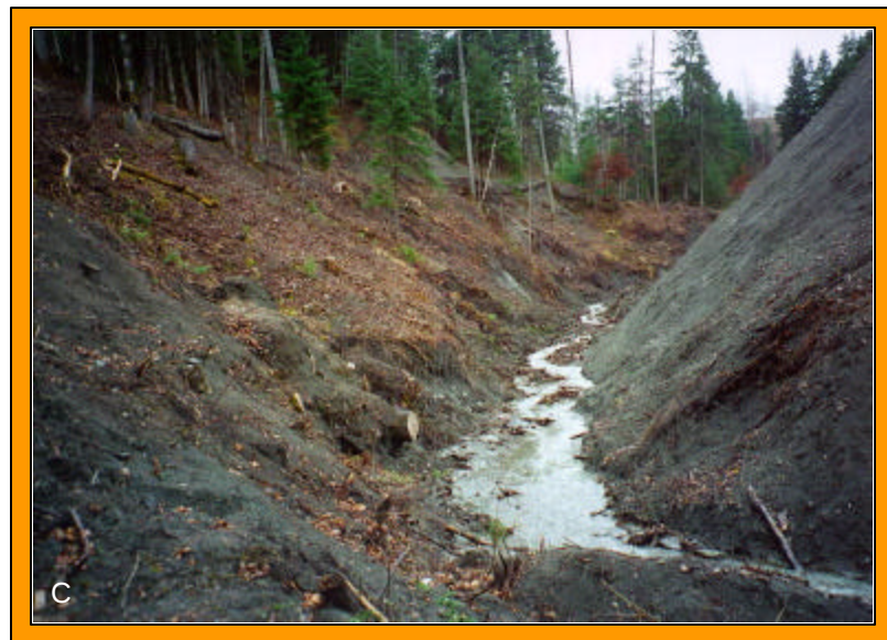
Figure 66 : Exemples d'érosion et de glissements superficiels dans le ruisseau Dufour (zone 4, fig. 53).
