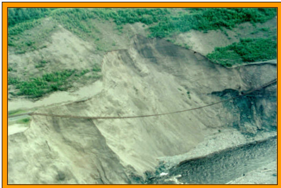
Figure 11 : Glissement majeur dans un talus de sable s'étant produit pendant la Crue; rivière à Mars, La Baie.
